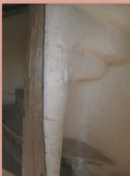
Vřetenové schodiště ve věži
