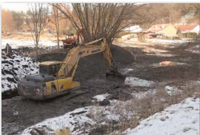
Budování prohlubní ve dně mokřadu, 18.2.2021
